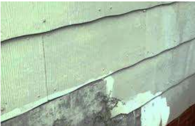
Asbestos siding
