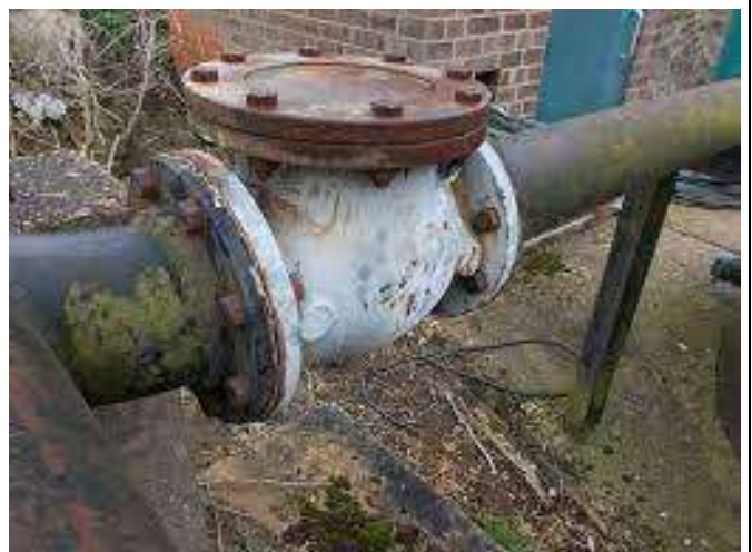
Asbestos gaskets
